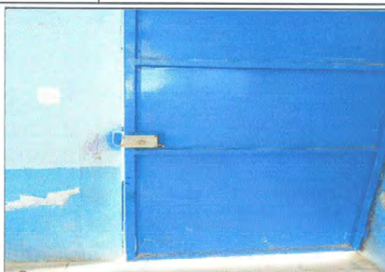
Foto 2: panorama de reparación de puertas
