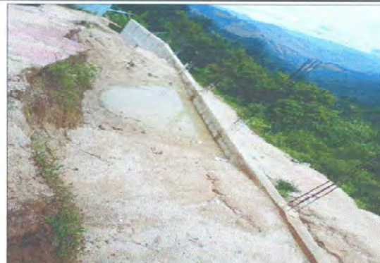
Foto 2: panorama de muro
