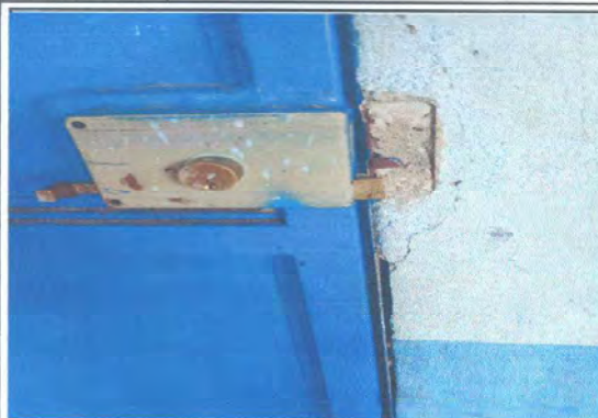
Foto1: panorama de reparación de puertas
